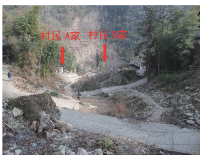
图 3 泥石流摧毁房屋
