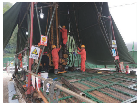
图2 CSD-1800型钻机开孔检查
