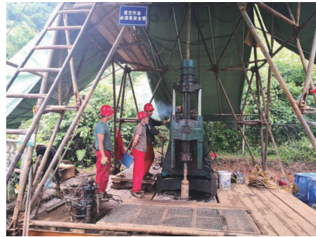
图1 XY-6型钻机开孔安全检查
