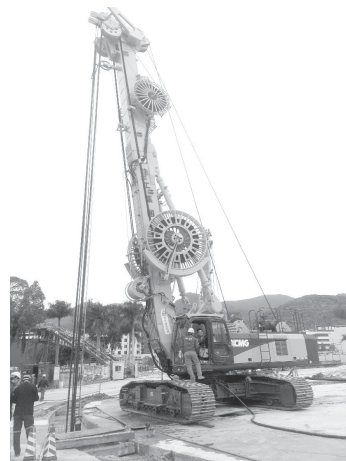
图7 XTC80/55型铣槽机现场施工
