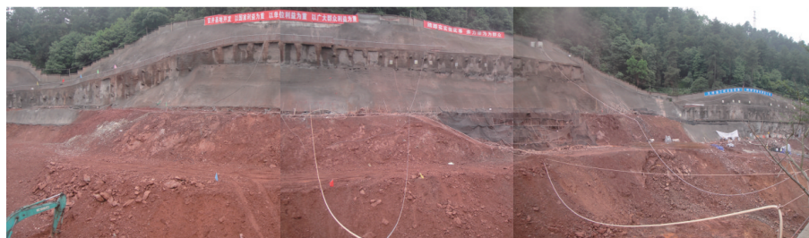
图1 官井基地滑坡治理工程施工现场
