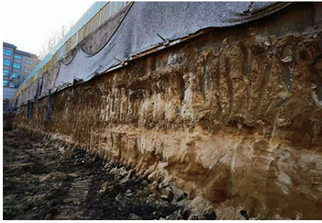
图3 现场开挖面施工效果
