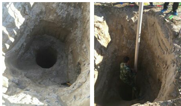
图 5 矿场现场建设的胶结质量评估标准孔
