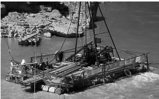
图 1 油桶筏结构实物图
