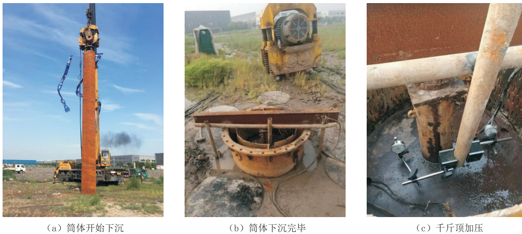
图 4 一次性免堆载试验现场
