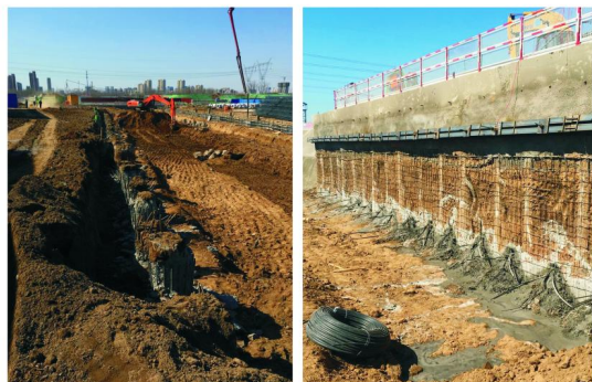
图2 钢筋笼顶及桩外侧效果
