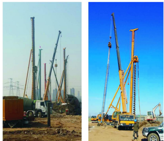
图 1 群机施工作业现场
