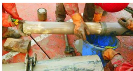
图2 三层管钻具取心
