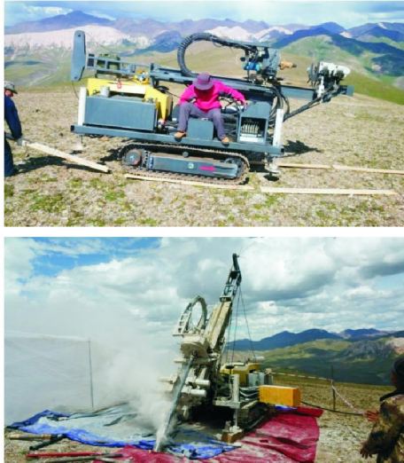
图5 多功能钻机搬迁及试验现场
