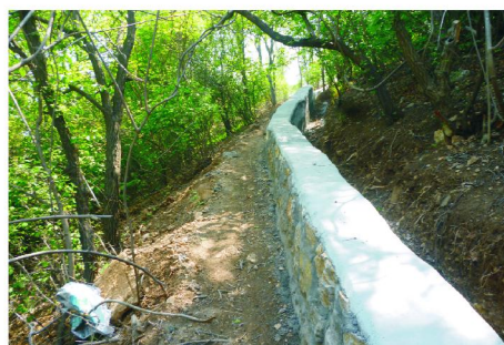
图6 施工的挡水墙
