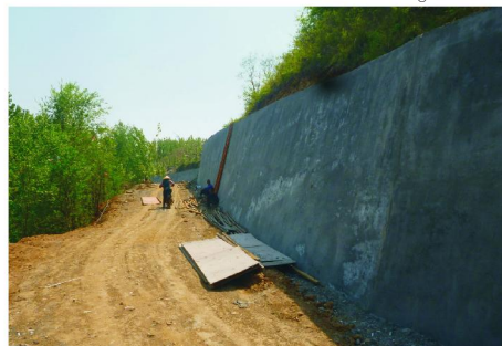
图5 施工的悬臂式挡墙
