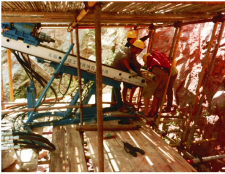
图1 钻机钻孔定位
