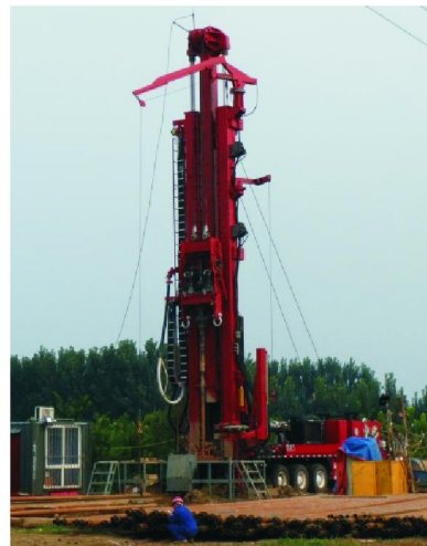
图8 地热井钻探施工现场
