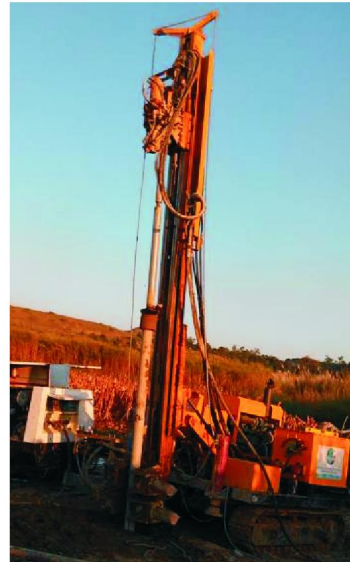
图5 空气潜孔锤钻进工艺
