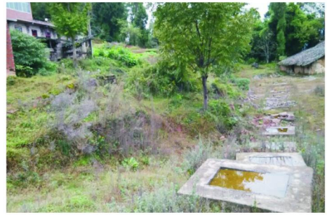
图8 抗滑桩现场照片
