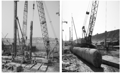
图 5 FCEC 全回转清障机拔桩施工现场
