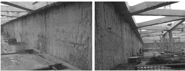
图5 TRD工法成墙照片
