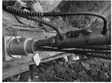
图 5 锚索应力计安装图
