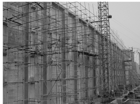
图5 建设中的滨江大道挡土墙锚固工程
