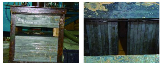
(a) 水平裂缝 (b) 垂直裂缝
