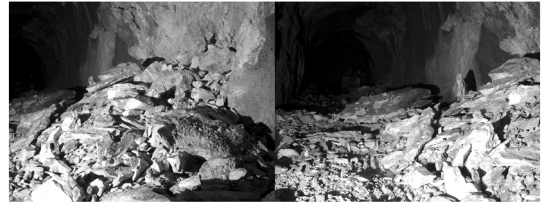
图1 BK14+672~713段右壁岩爆照片
