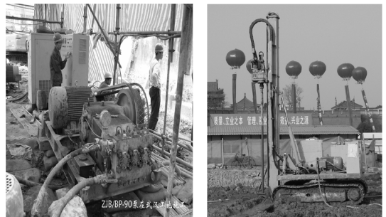
图 7 设备施工现场
