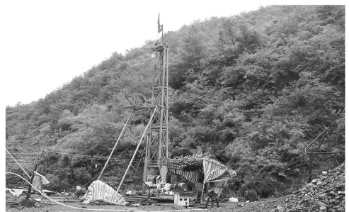
图 2 钻塔直立施工图
