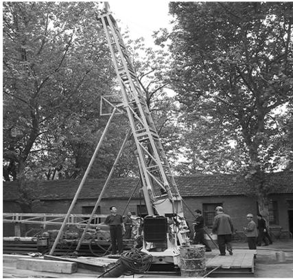
图3 钻塔斜立施工图
