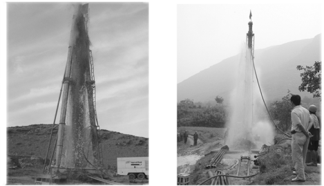
图6 散装和车装转盘钻机施工应用初始状态现场
