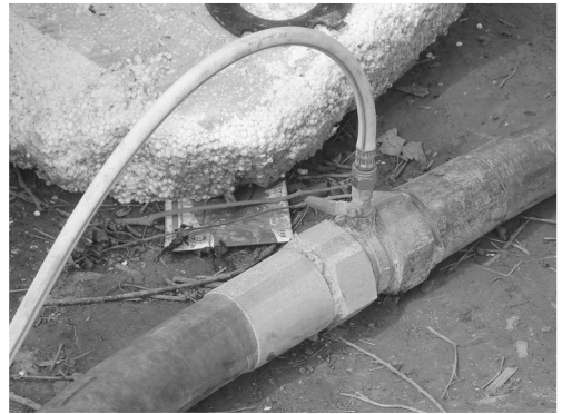
图4 注入泡沫管路和空气管路的连接
