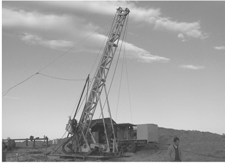
图2 XD-3型钻机在新疆克拉玛依矿区施工现场
